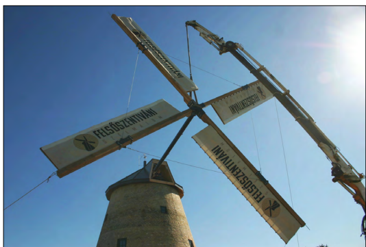
6. ábra. A szélkerék felemelése, helyretétele
