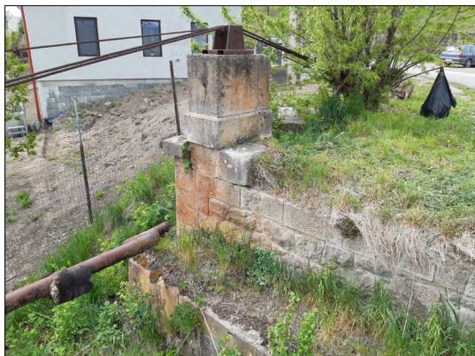
2. ábra. A híd fő jelenlegi állapotában
