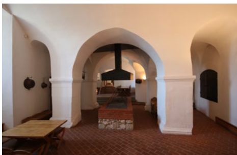
19. Sárospatak, reneszánsz Rákóczi fejedelmi várkastély földszintjén a reneszánsz konyha tűzterét lehatároló füstvezető gerendákon nyugvó homlokfalak nélkül
