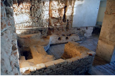
50. Pécel, gróf Ráday Gedeon kastélya a barokk konyhában feltárt sarok kemence alaptest és mellette két oldalt az előre feltételezett főzőkatlanok
