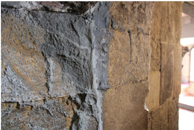
23. Részlet a Szent István-terem keleti ajtaja déli oldali keretének és a lépcsőház déli oldalfalának kapcsolódásáról
