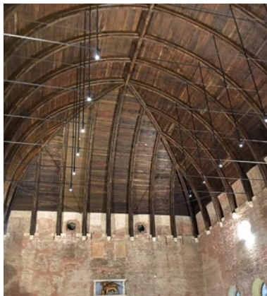
5. Vicenza, Basilica 14. századi nagyterme, a címerköveken a süllyesztett boltindítás és a vonórúdak láthatók
