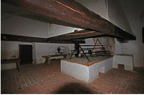
12. Fraknó [Forchtenstein], Esterházy hercegi várkastély, a reneszánsz konyha a keresztgerendákon nyugvó füstkupolával és alatta a tűzipadka
