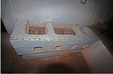
14. Fraknó [Forchtenstein], Esterházy hercegi várkastély, a reneszánsz konyhában a főzőkatlansor a tűztér alatt
