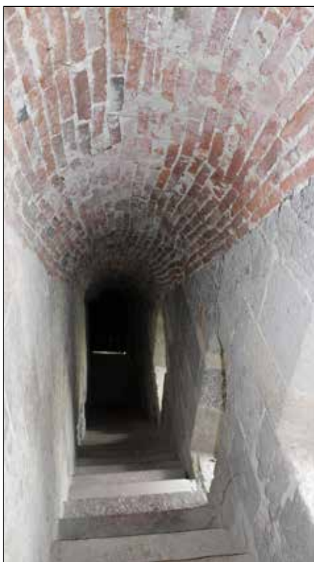
21. kép A Lakótorony északi helyiségébe vezető lépcsőház részlete a nyugati falba vágott ablakokkal
