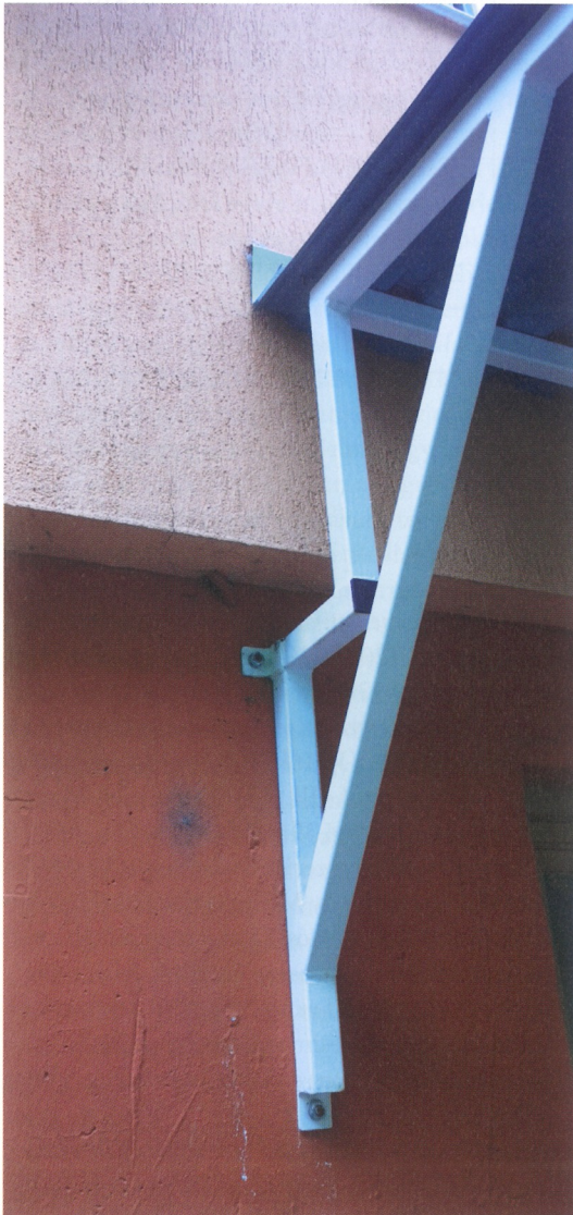
3. ábra: Az előtetőt tartó konzol rögzítése
