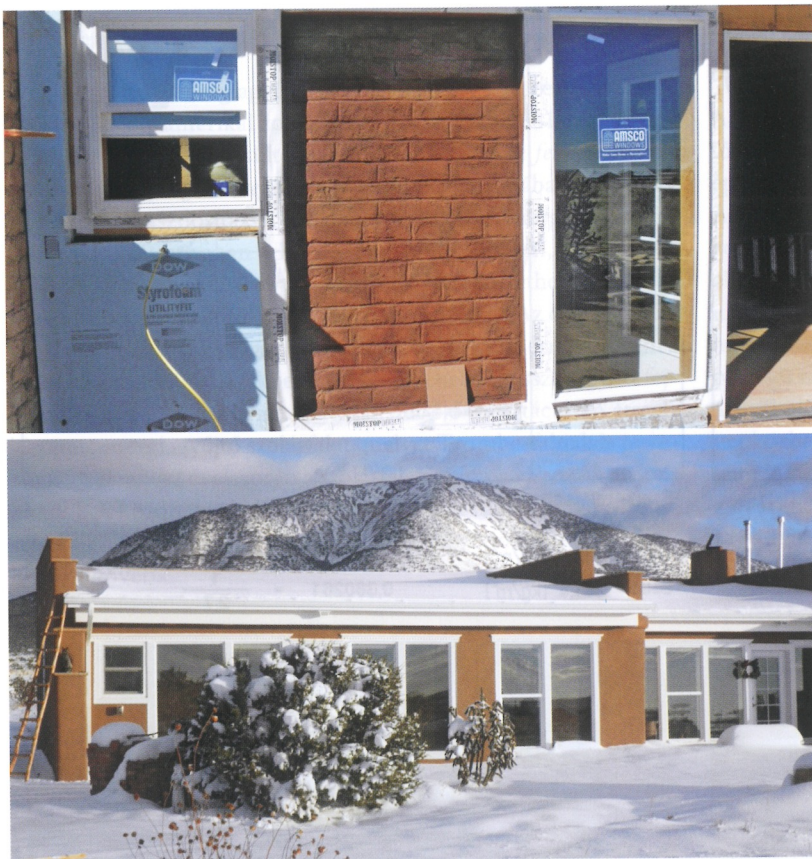
5. ábra: Energiagyűjtő földtégla falakkal rendelkező családi ház a Santa Fé-ben, Új-Mexikó állam, USA [6]
