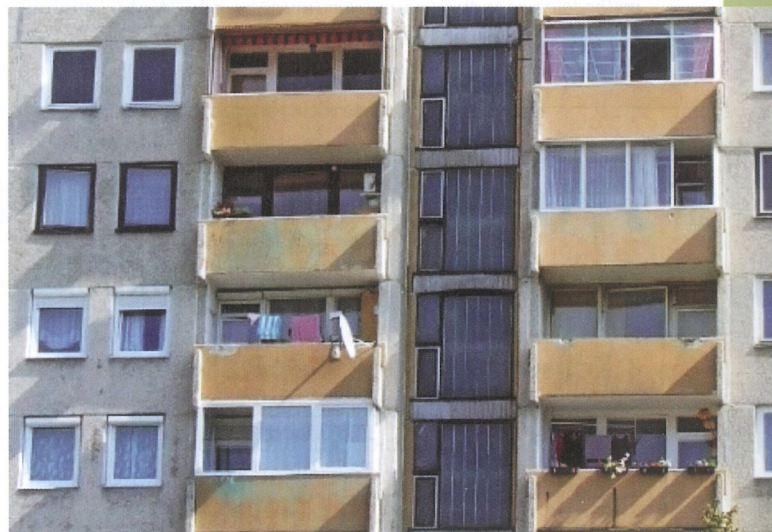
4. ábra: Beüvegezett erkélyek és kopolitüvegfalú lépcsőház paneles épületnél (forrás: dobozolo.blog.hu)
