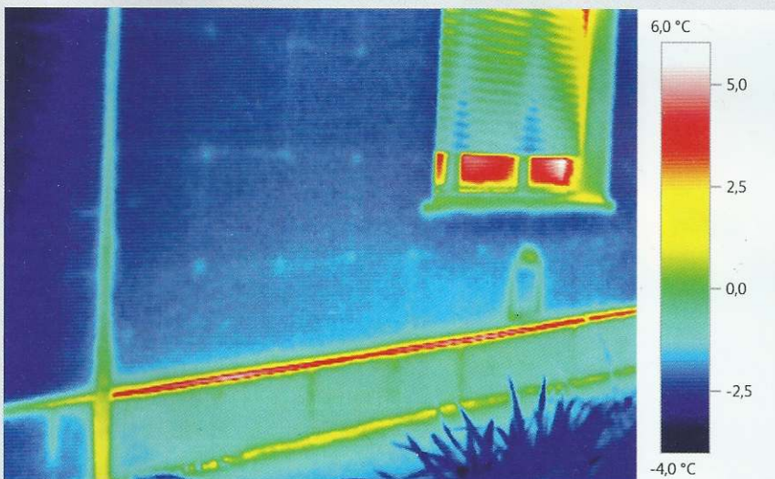
3. ábra: Lábazat és hőszigetelt homlokzati fal dübelezési, szigetelési és csatlakozási hiányosságai hőfényképen
