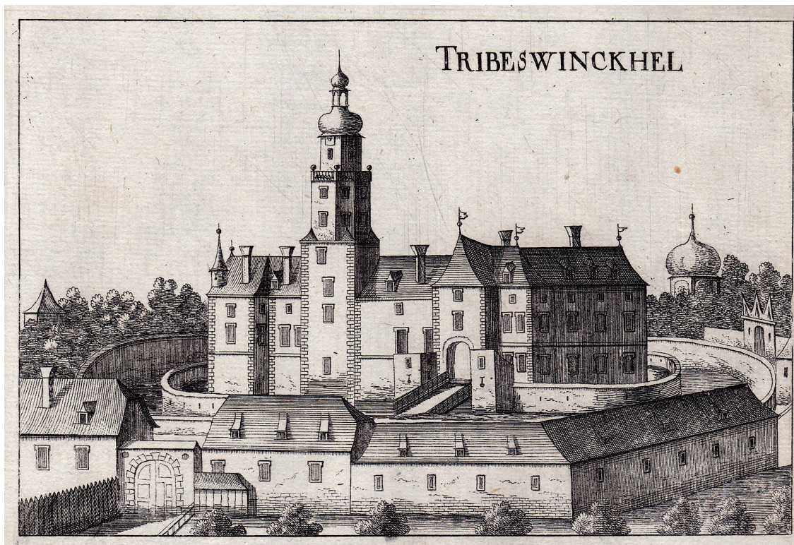
12. kép. Tribuswinkel látképe, Georg Matthäus Vischer: Topographia archiducatus Austriae Inferioris modernae , S. l., 1672. Rézmetszet
