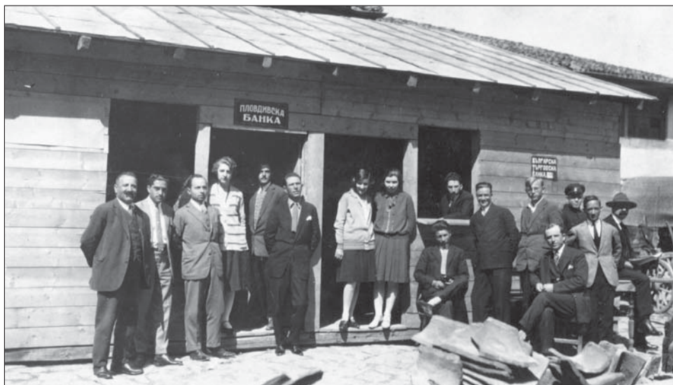
24. kép. A plovdivi népbank személyzete a bank épülete előtt, 1928
