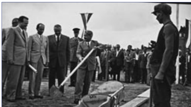
15. ábra. Tildy Zoltán köztársasági Elnök 1948-ban megkezdi a Népstadion építkezését
