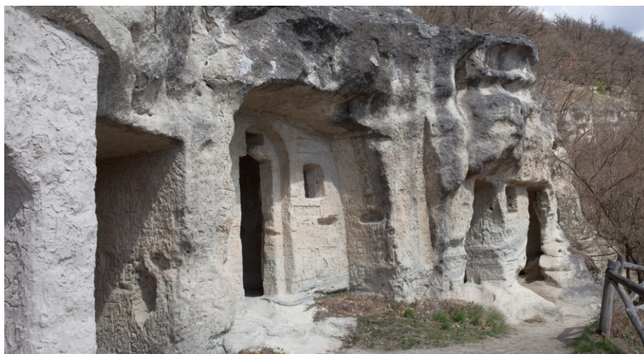
37. kép. A szentkúti remetebarlangok bejárata (fotó: Földi Zsolt, 2018)
