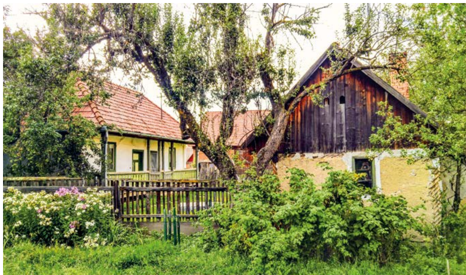
1. kép. Az élet (porta) épületei és térbeosztása: ház, csűr, nyári konyha, kert, első udvar, hátussó udvar.
