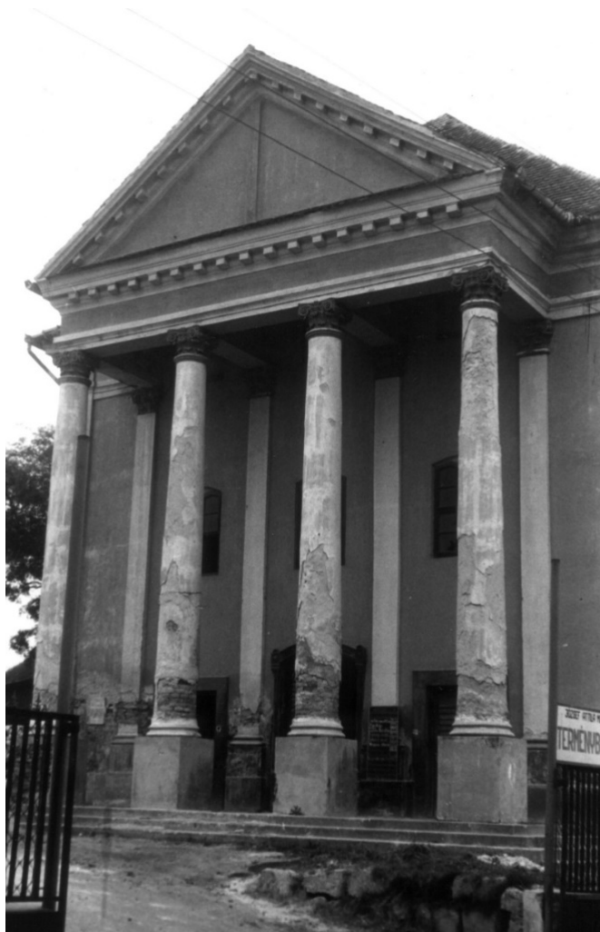
6. kép. Az 1825-ben épült abonyi zsinagóga, feltehetőleg szintén Landherr András alkotása 1983-ban. (Fortepan/Gazda Anikó, képszám: 141147 )
