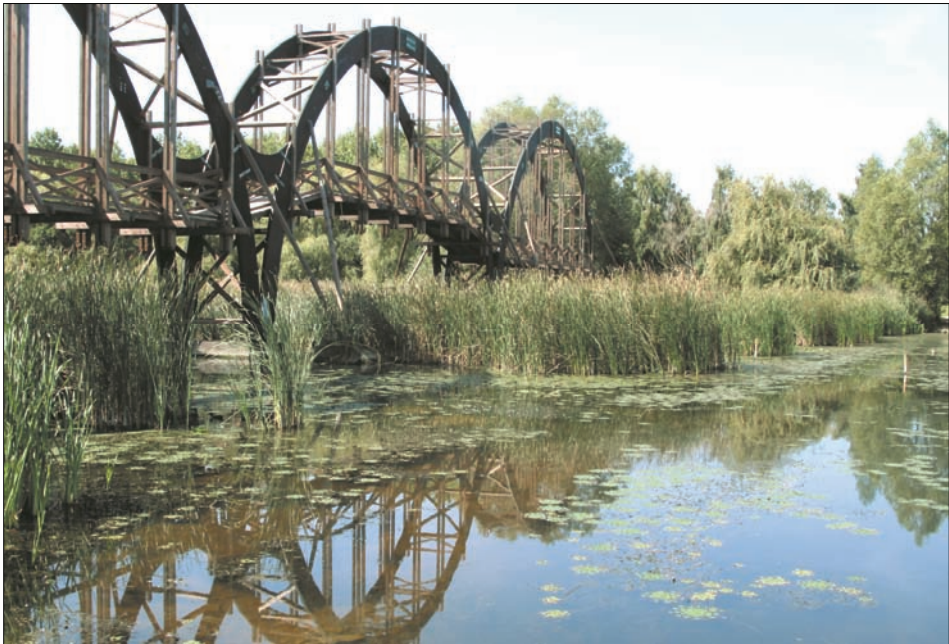
138. ábra: A Kis-Balaton részlete a Kányavári-szigetre vezető híddal
