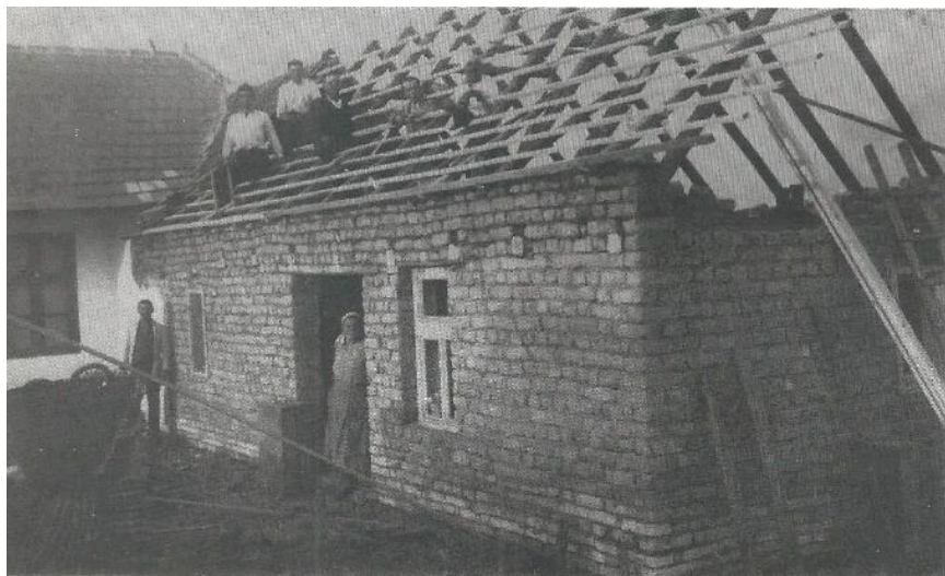
1. kép Bordély építése 34
