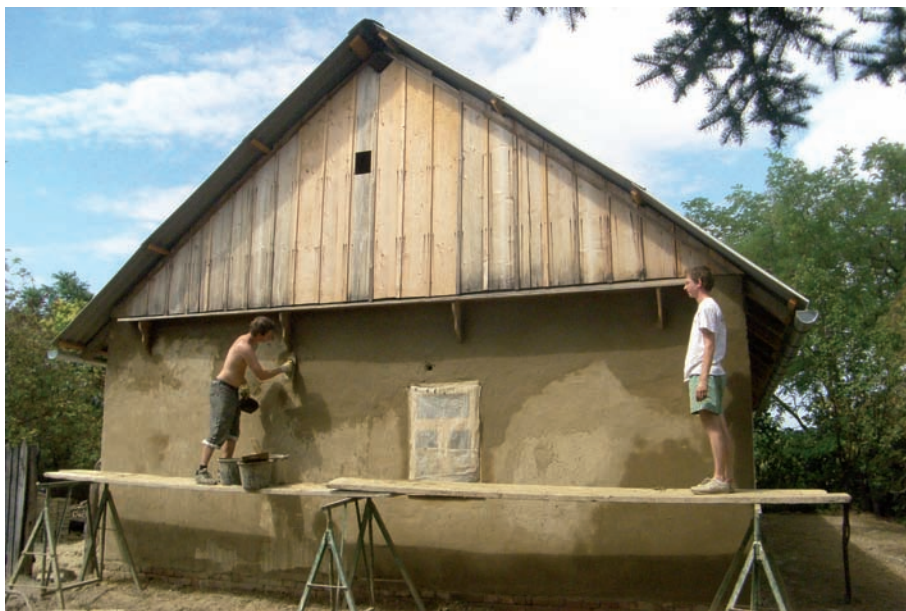
20. kép: A keleti homlokzat felújítás alatt, 2012.
