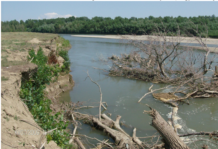
34. ábra. Uszadékok és erodálódó partszakasz Tiszabökénynél (Nagyszőlősi járás)
