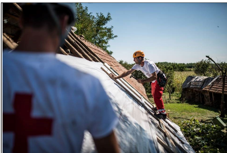
6. sz. kép: Tetőhelyreállítás Rozsályon a 2016. júniusi viharkárok után
