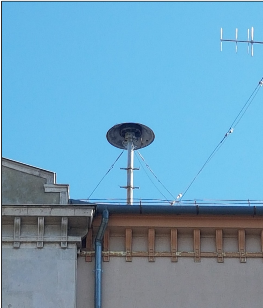
4. számú kép: Polgári védelmi sziréna épület tetején. A fotót készítette: a szerző.
