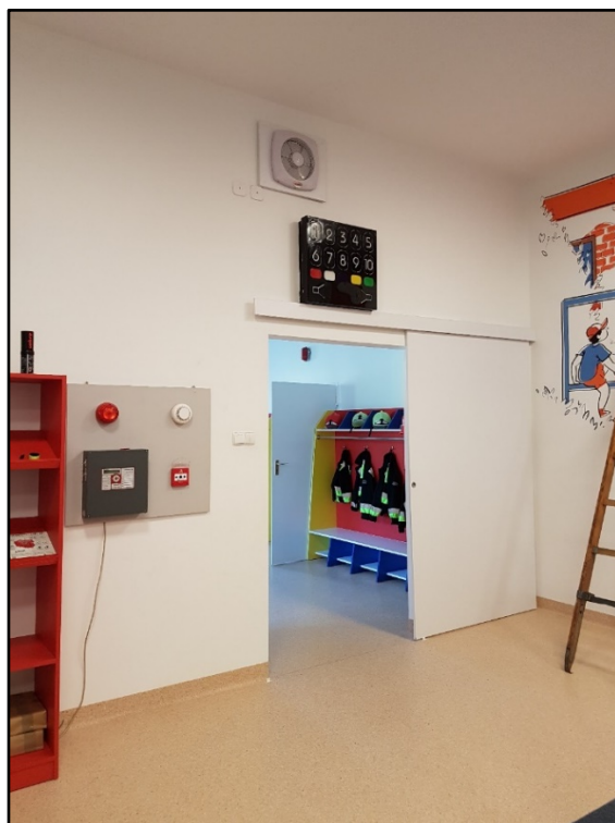
33. számú kép: A torún-i katasztrófavédelmi lakosságfelkészítő terem bejárata. A fotót készítette: a szerző.
