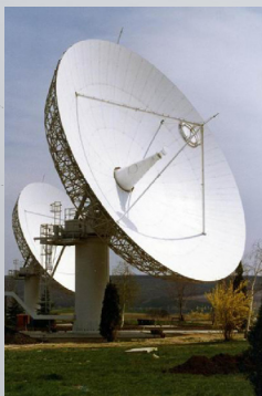
A Taliándörögdi Földi Állomás a 60 tonnás Cassegrain antennával a tetején
