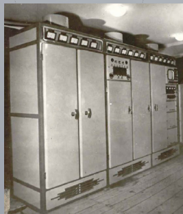
A BHG 1/0,4 kW-os tv adója a Hargita Szállóban
