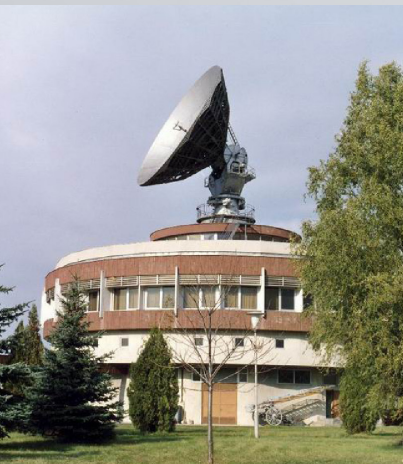
A Taliándörögdi Földi Állomás a 60 tonnás Cassegrain antennával a tetején
