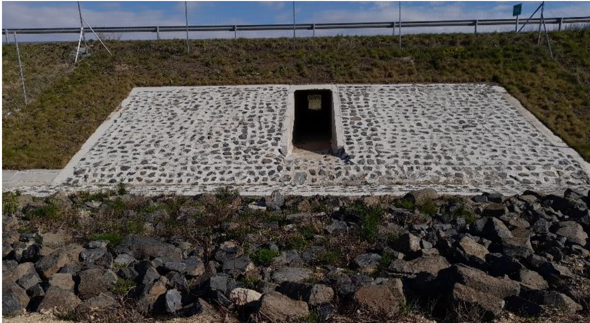
1. ábra: Vizsgálatba bevont közúti műtárgy képe
