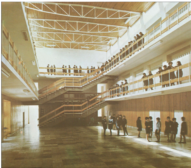
8. ábra. A szerencsi Bocskai István Gimnázium belső aulaterre, egykarú, kéttagú lépcsővel és acél rácsostartó tartószerkezeti térlefedéssel. (Forrás: Kmetty Gyula [szerk.]: Északterv Műszaki Tájékoztató 1978. Építésügyi Tájékoztatási Központ, Budapest 1979)
