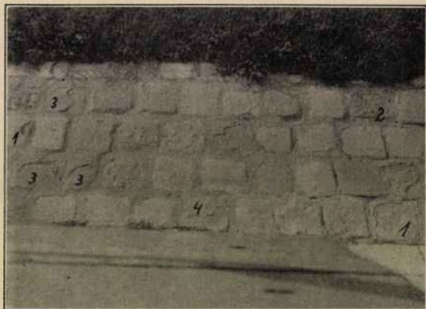
2. kép. A Gellért-hegy déli tővében, a Kelenhegyi-út északi oldalán lévő támfal egyik részlete. A kőköcskák legtöbbször andezit. 1 = andezit a Csák-hegyről (Szob). 2 = gránit (Mauthausen). 3 = megsárgult andezit (Dunabogdány, Csódi-hegy). 4 = kék andezit (ugyanonnan).
