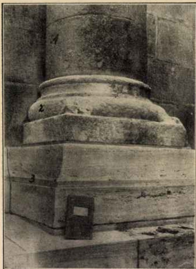
5. kép. A pécsi székesegyház egyik oszlopának részlete. 1 = miocén homokkő, 2 = miocén mészkő, 3 = triász mészkő. Mindegyik kőzeten látszik a mállás hatása. Az alsó részen (3) szaturák is szembetűnnek.
