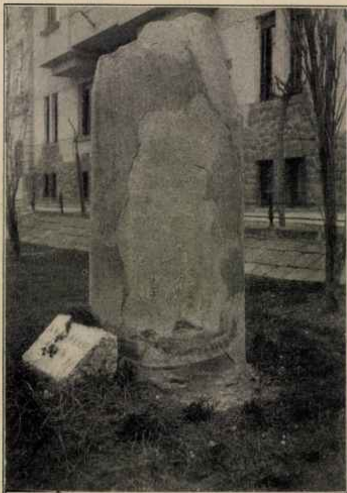
1. kép. A székesfehérvári Szent István székesegyház bioltos amfibol-gránit oszlopa. Vékony lemezekben pereg le a gránit.
