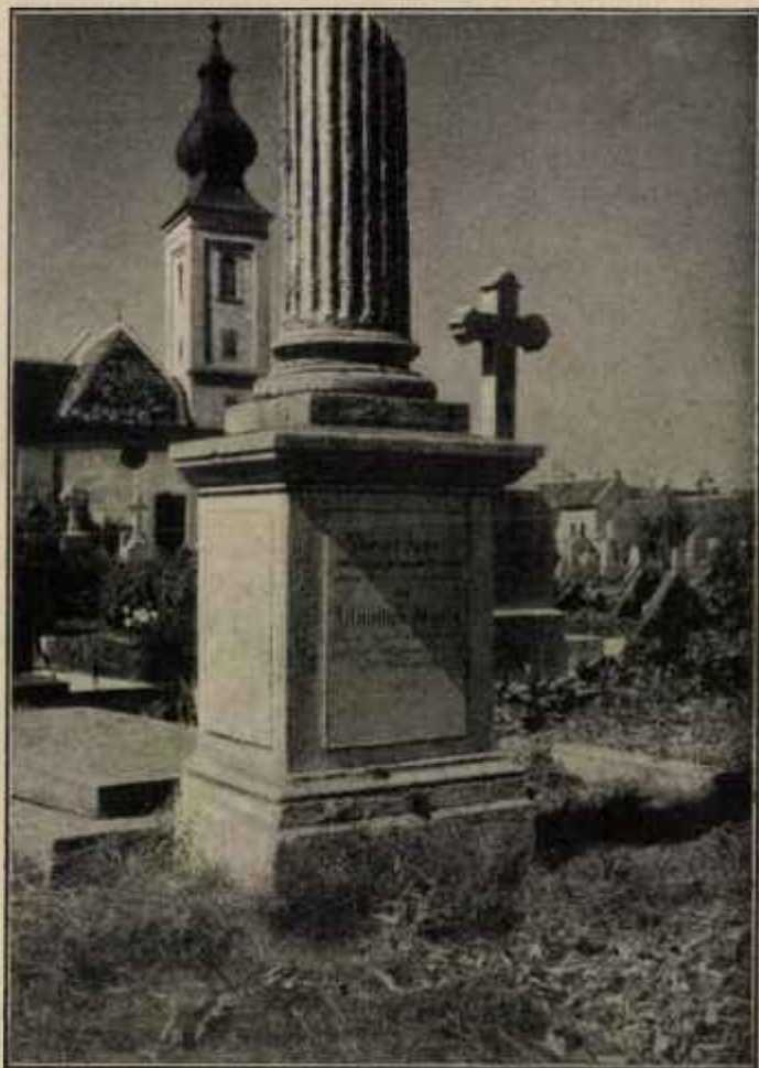
7. kép. 1861-ben felállított síremlék lajtméscskőből (Szombathely). A mállás hatása főképp az oszlop felső, bordázott részén, valamint legalul feltűnő.
