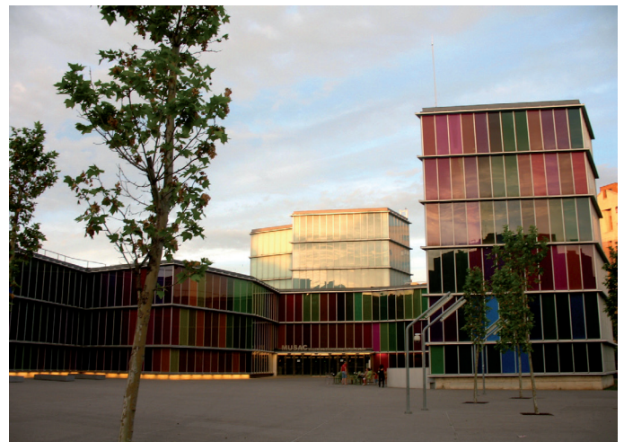
Fig. 2. MUSAC, León, 2004. Architect: Mansilla&Tuñón.
