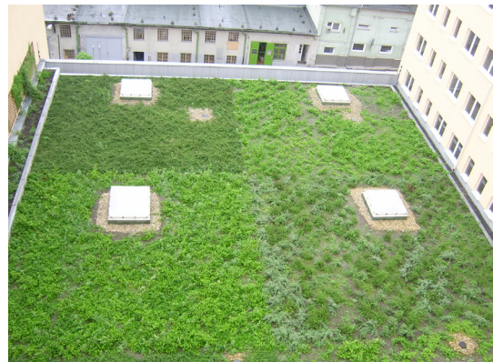
3. ábra. Felülvilágítókat elválasztó kavicssáv zöldtetőn.
