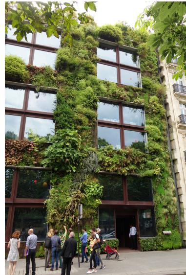
10. ábra. Felületi beültetés függőleges vegetációs zónával Párizs, Quai Branly Jacques Chirac Múzeum.
