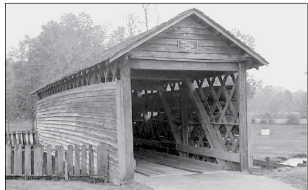
17. ábra A Coldwater híd. A tartókra szerelt rácszat a vízszintes palánkozást hivatott megtartani (Forrás: Dale J. Travis, 2007)
