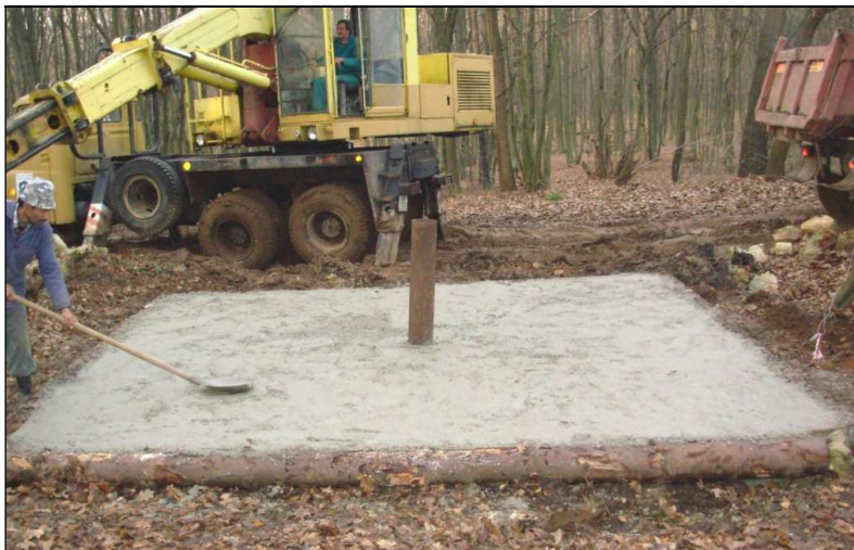
A nyílás bebetonozása.
