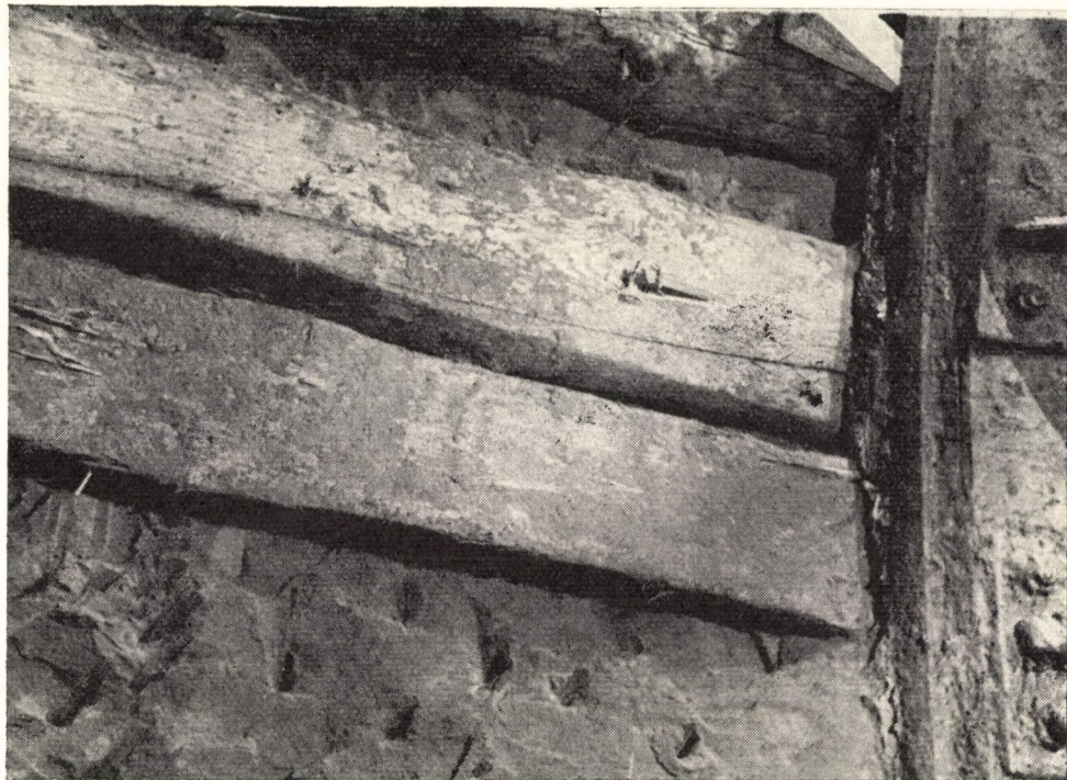
4. ábra. Túlfejtés és pallóval való tömedékelés
