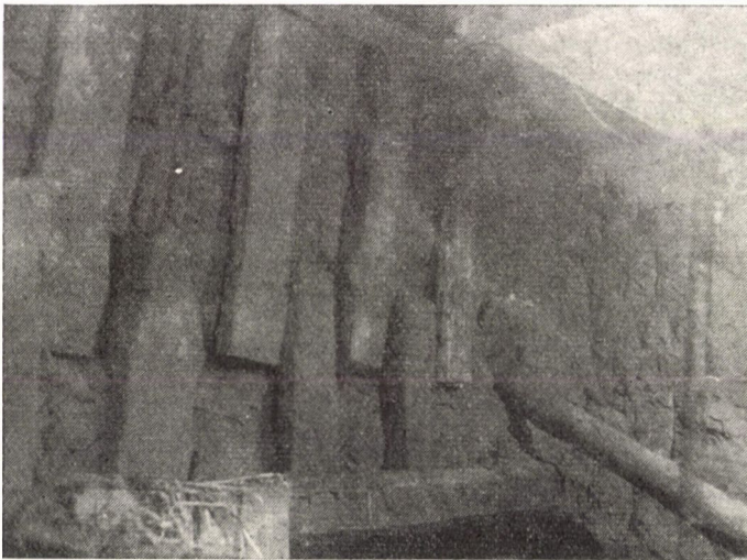
38. ábra. Ellendúc a pajzs irányításában való befolyásolására
