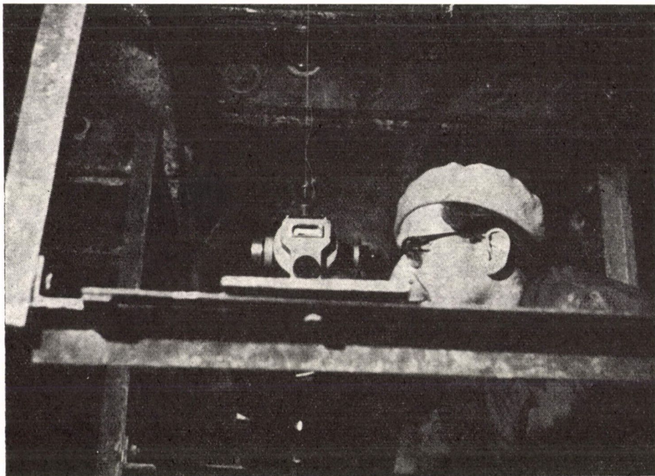
29. ábra. A pajzs vízszintes helyzetét meghatározó adatainak mérése magas állásról
