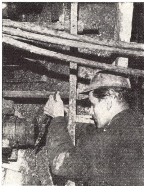
40. ábra. A pajzs visszacsavarása egyszerű vasékkal
