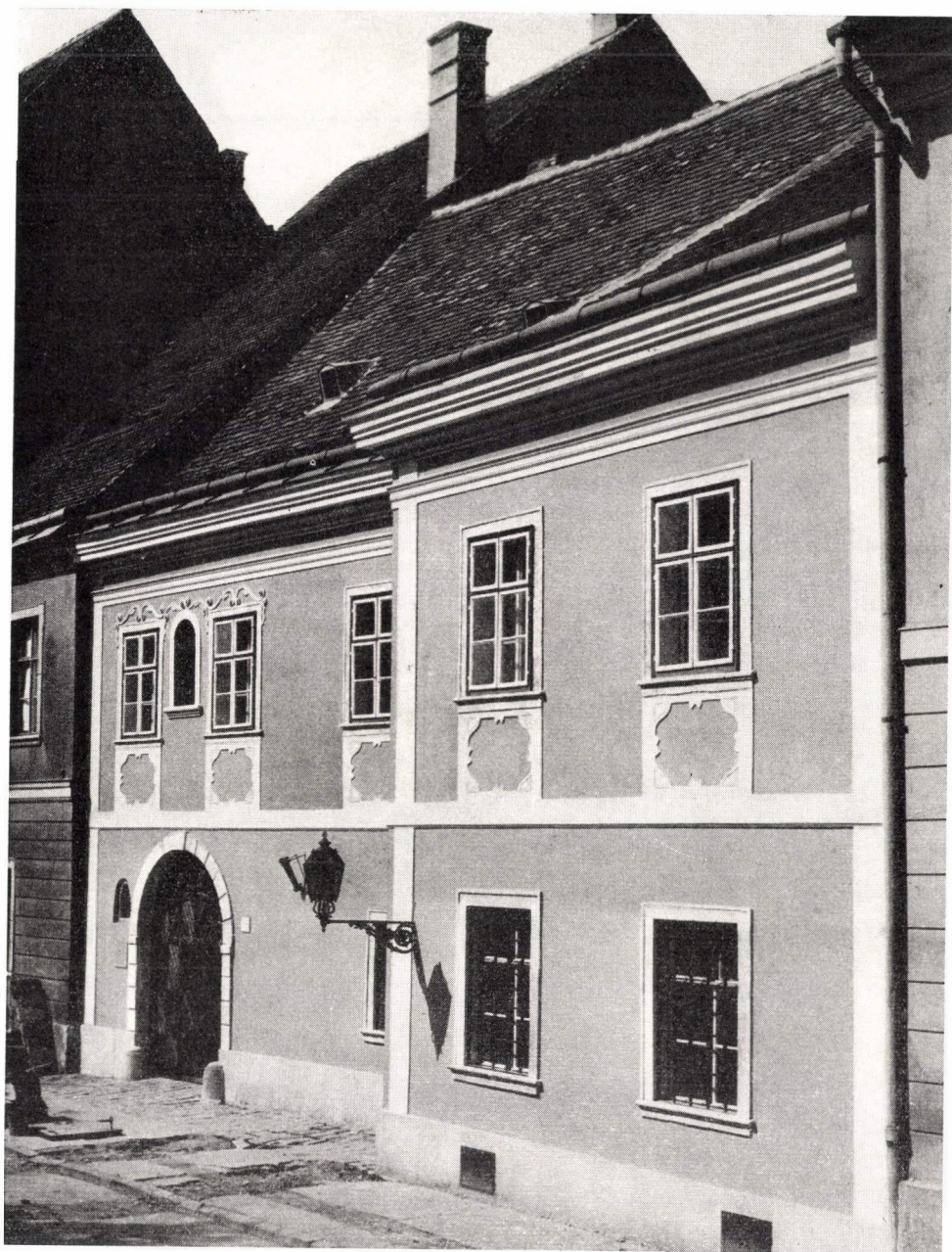
2. Bp. I. Úri u. 45. „EMFIX”-el színezett homlokzat 2. Budapest I. Úri-Gasse 45. Fassade, mit »EMFIX« gefärbt
