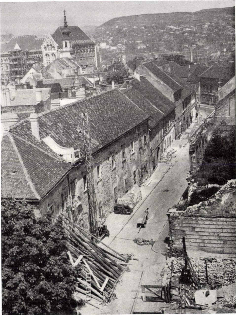
1. Budapest I. Hess András tér 3. sz. lakóház helyreállítása a budai várnegyedben 1. Budapest I. Hess András-Platz No. 3. Wiederherstellung eines Wohnhauses im Budaer Festungsviertel
