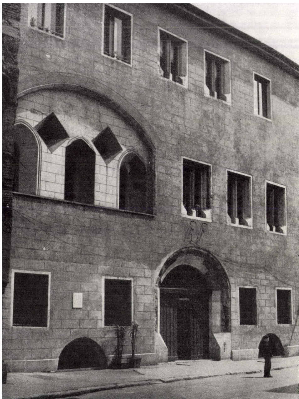
3. Bp. I. Úri u. 31. Homlokzatvakoló habarcs téglaporral színezve 3. Budapest I. Úri-Gasse 31. Mörtel zum Fassaden-Verputzen, mit Ziegelpulver gefärbt
