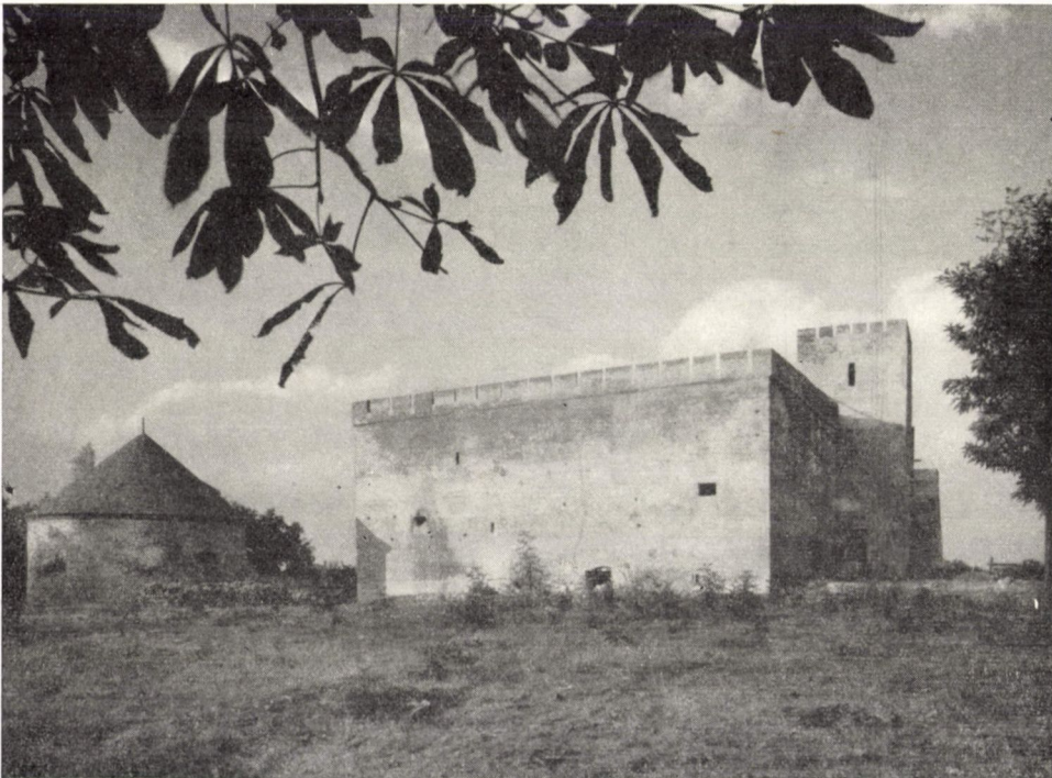
6. Gyula, vár és ágyútorony. Helyreállítás tervezője: Erdei Ferenc 6. Gyula, Burg und Kanonenturm. Projektíngenieur der Herstellung: Ferenc Erdei
