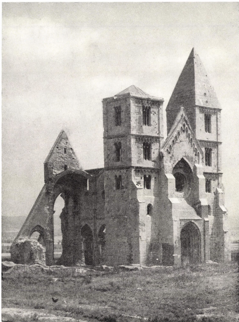
1. Zsámbék, templomrom állagmegóvása. Helyreállítás tervezője: Möller István 1. Zsámbék, Bestandsicherung der Kirchenruine. Projektingenieur der Herstellung: István Möller
