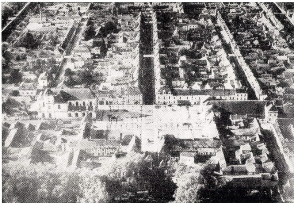
23. ábra. Richelieu 1631. évi alapítású város légiképe, az előtérben a főútra szimmetrikus főtér látható
