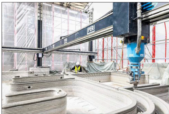
15. ábra: COBOD BOD2 3D nyomtató munka közben (Kalácska, 2020)
