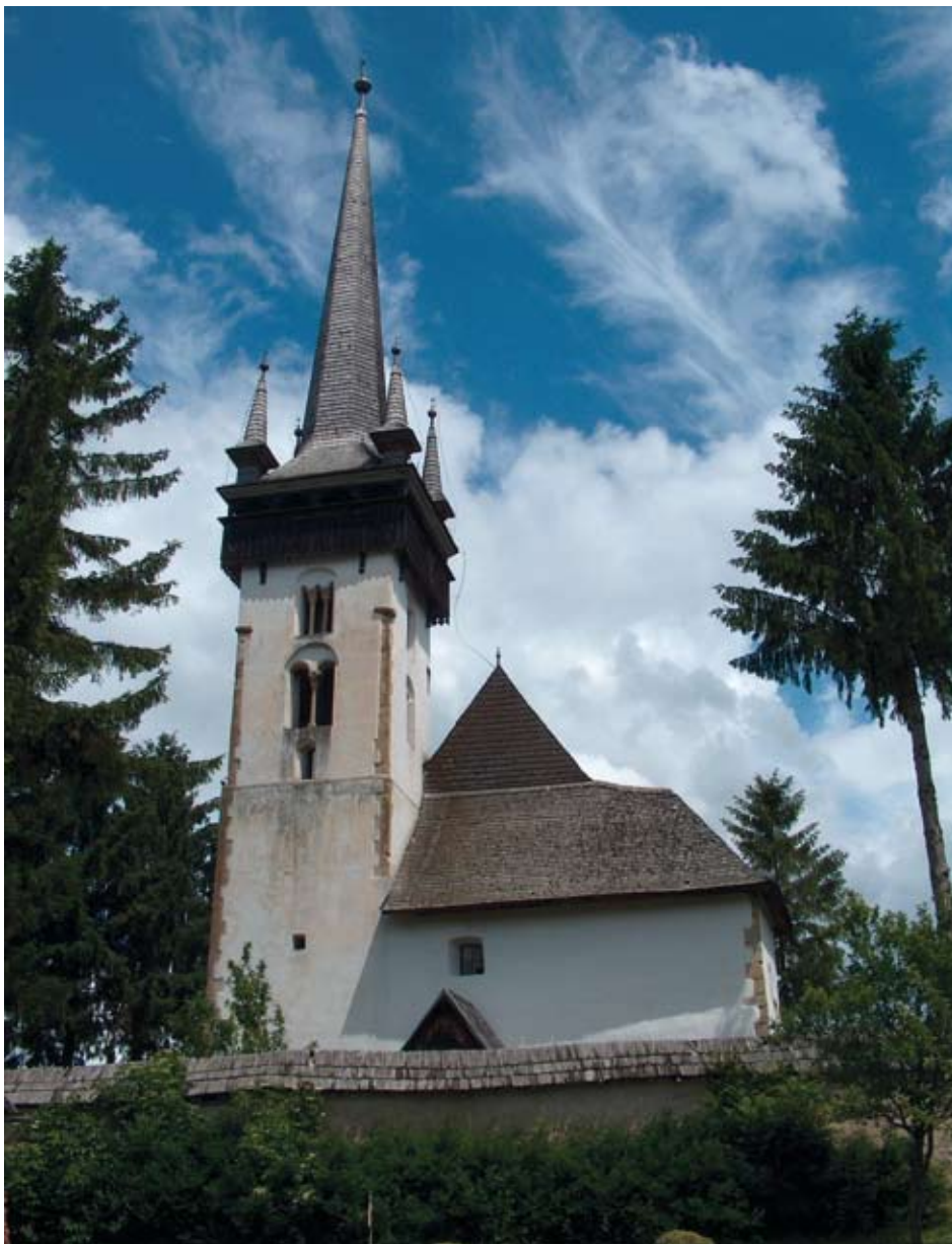
8. kép: Magyargyerőmonostor középkori eredetű, a bencés építőhagyományokat őrző templomának egykori kettős nyugati homlokzati torony párjából az északi maradt meg, amelyre az 1830-as években a torony megerősítése után került a toronysisak. Malonyay Dezső 1907-ben írja: „Külön érdekessége van abban, hogy erre az időmegviselt, sok száz éves romra fölépítették a magyaros új toronytetőt, zöldre füstött harangházzal, piros cserepes sisakkal.” (Malonyay 1907: 78) (Fotó: Fülemile Ágnes, 2005)
