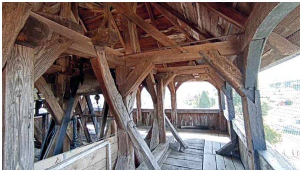
11. kép: Kraszna középkori eredetű református templomának 1708-ra elkészült erkélyes, körüljárós harangházának faszervezete (Fotó: Fülemlé Ágnes, 2023)
