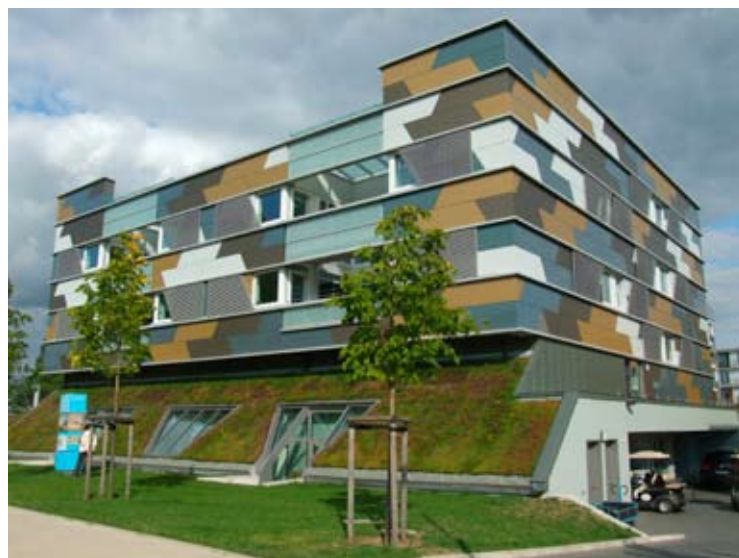
„HIBRID HÁZ”, ÉPÍTÉS: NÁGELIARCHITEKTEK
