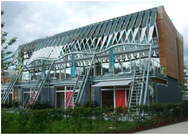
„OKOS ANYAGÚ HÁZ” BEFEJEZÉS KÖZELI ÁLLAPOTBAN, ÉPÍTÉSZEK: KENNEDY & VIOLICH (BOSTON); 360 GRAD+
