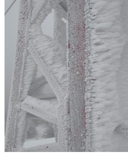
2. ábra. Tartóoszlopon megfigyelhető jegesedés
