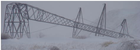
3. ábra. Szél- és jégteher hatása (forrás: http://www.electrica.ro/comunicat-de-presa-7-02-2012/ )
