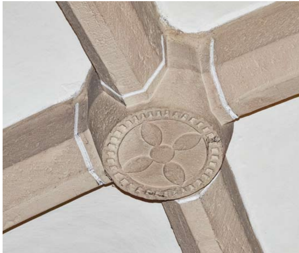
2.2.20. Száztelek, a szentély élszedékes bordája és a zárókő 2.2.21. Szepesedelény, a szentély bordája és zárókőve
