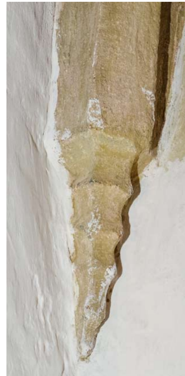
2.2.56. Lőcse, boltozatindítás a minorita templom északnyugati sarkában
