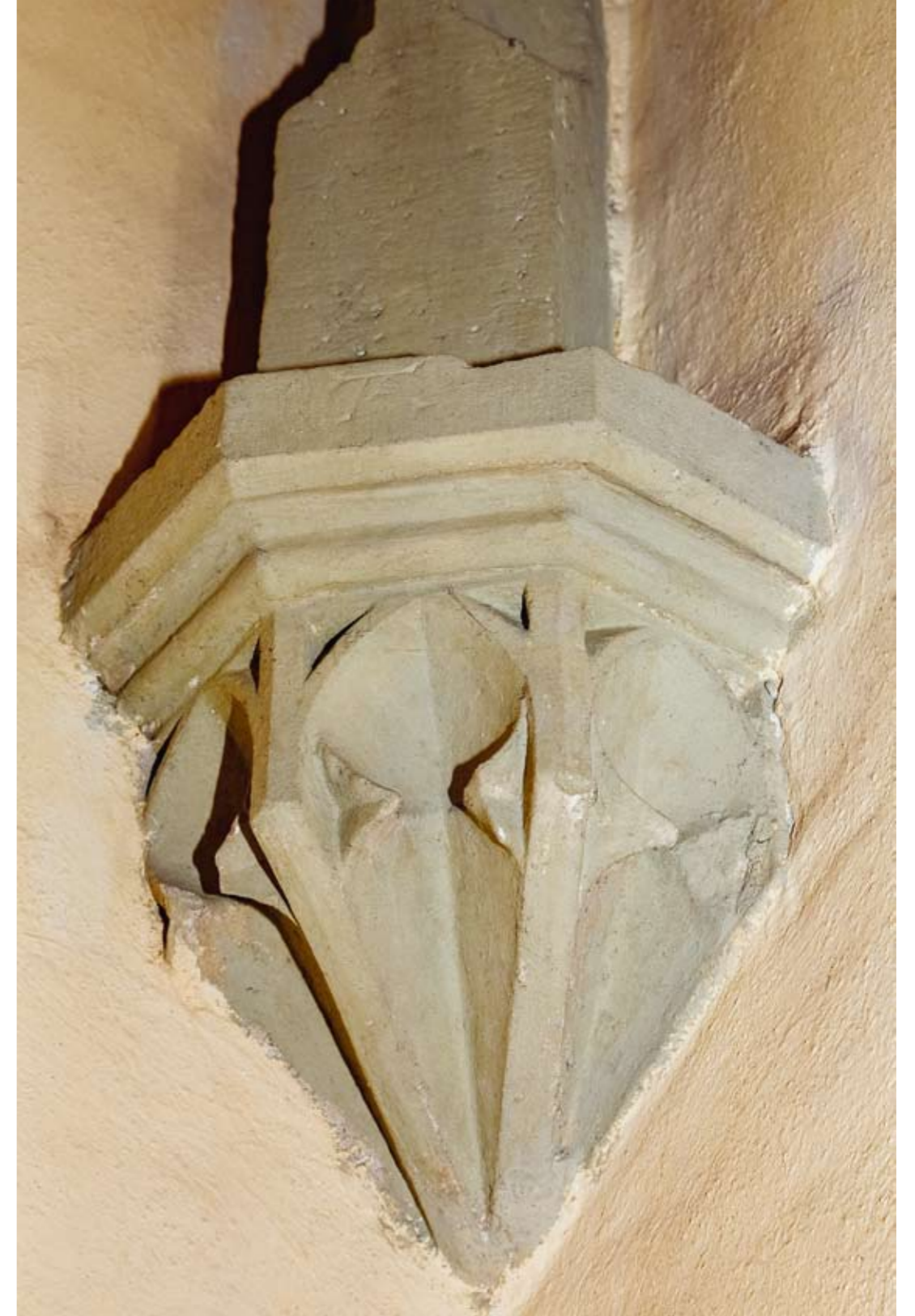
2.2.58. Nagylósva, a szentély északkeleti, vakmérnöves konzola
