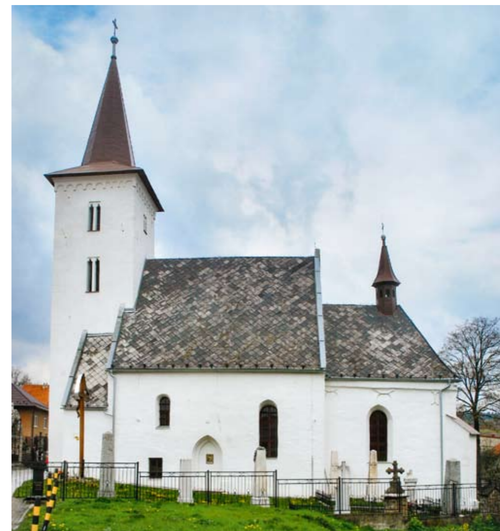
1.3.24. A szepeskörtvélyesi templom déli homlokzata a restaurálás előtt 1.3.25. A szepeskörtvélyesi templom déli homlokzata a restaurálás után
