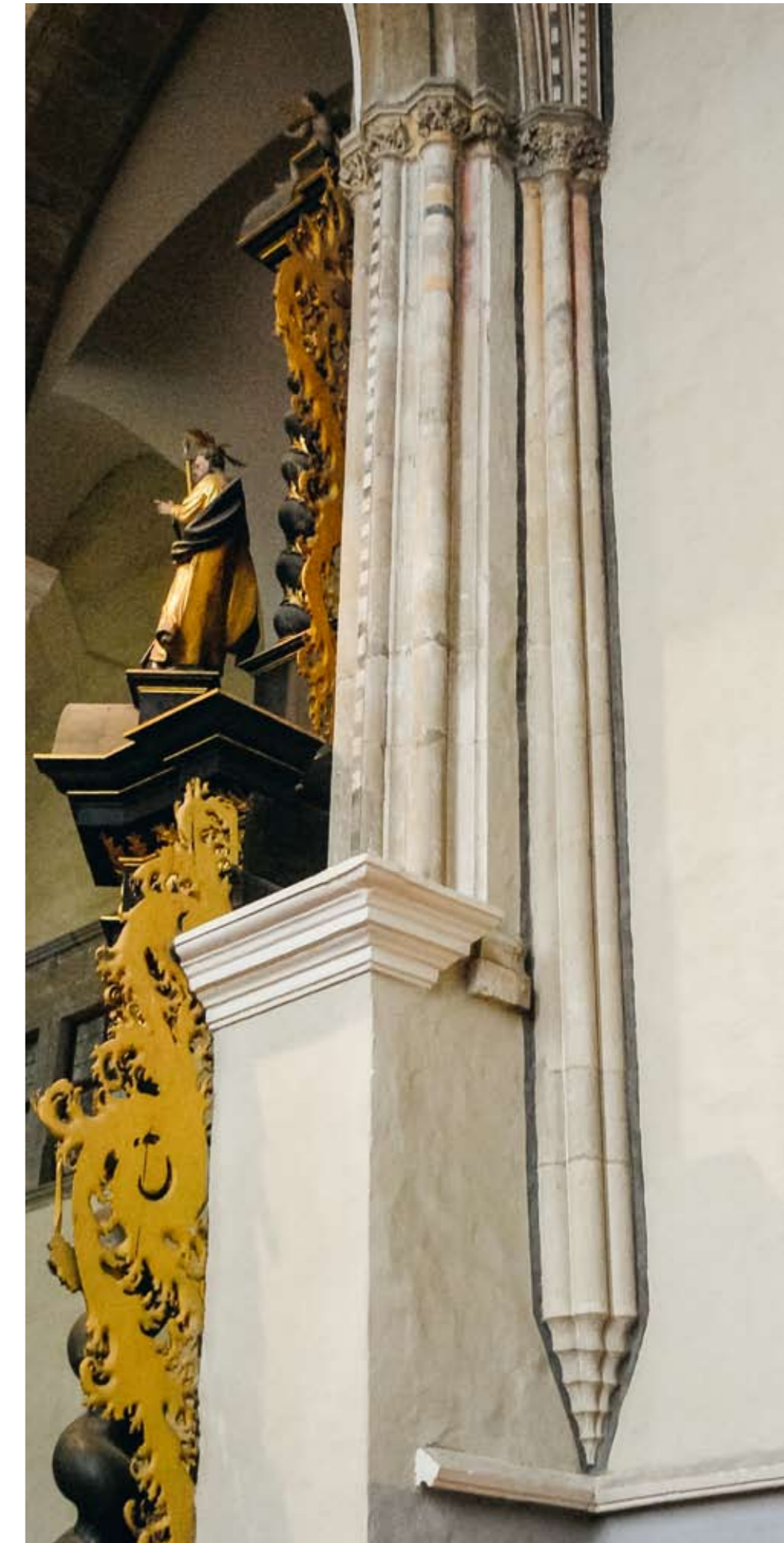
2.2.56. Lőcse, boltozatindítás a minorita templom északnyugati sarkában
