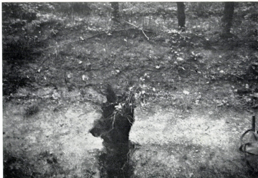
11. kép. Alábányászás következtében kialakult 20–25 cm széles, 50–70 m hosszú hasadék Komlón (Béta akna) 20–25 cm wide and 50–70 m long fissure formed as a result of undermining at Komló (Béta shaft)
