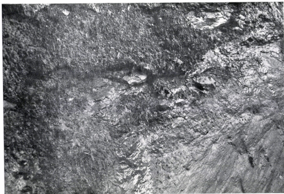
1. kép. Rétegvízszivárgás a csúszópálya mentén vékony (1–2 cm) homokrétegekkel tagolt, kékeszürke pannóniai agyagból. A szivárgó víz 100–150 m-es szakaszon jellemző (Neszemély) Seepage of ground water along the shear plane which is a bluish-grey clay surface intercalated with thin sandy layers (1–2 cm)
