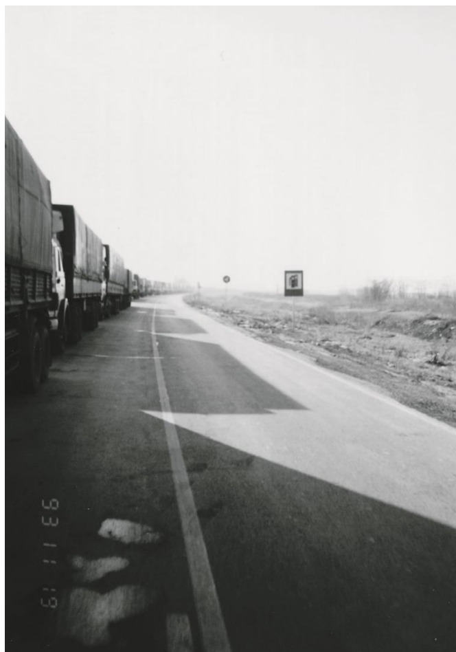
18a-c ábra: A 4-es főút Záhonynál A fényképeket helyi lakosok készítették
