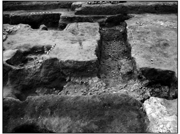
10. kép: A Ny-i oldal cementálódott apró köves alapozása
