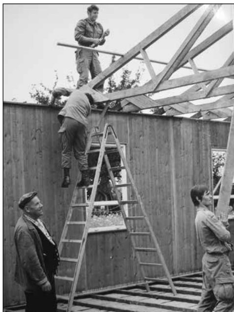
Bauarbeiten an der Holzkirche. Foto: Archiv der Kirchengemeinde Hochberg
