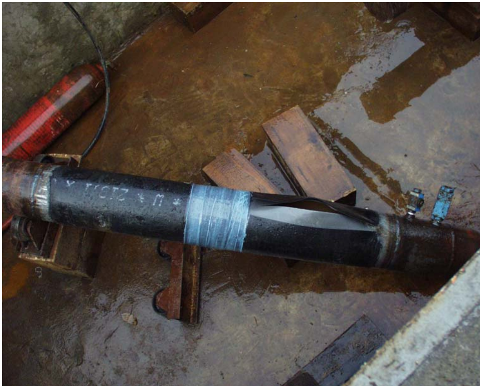
31. ábra. A kívülről megerősített DN 200-as csőszakasz (b3) a repesztővizsgálat után.
