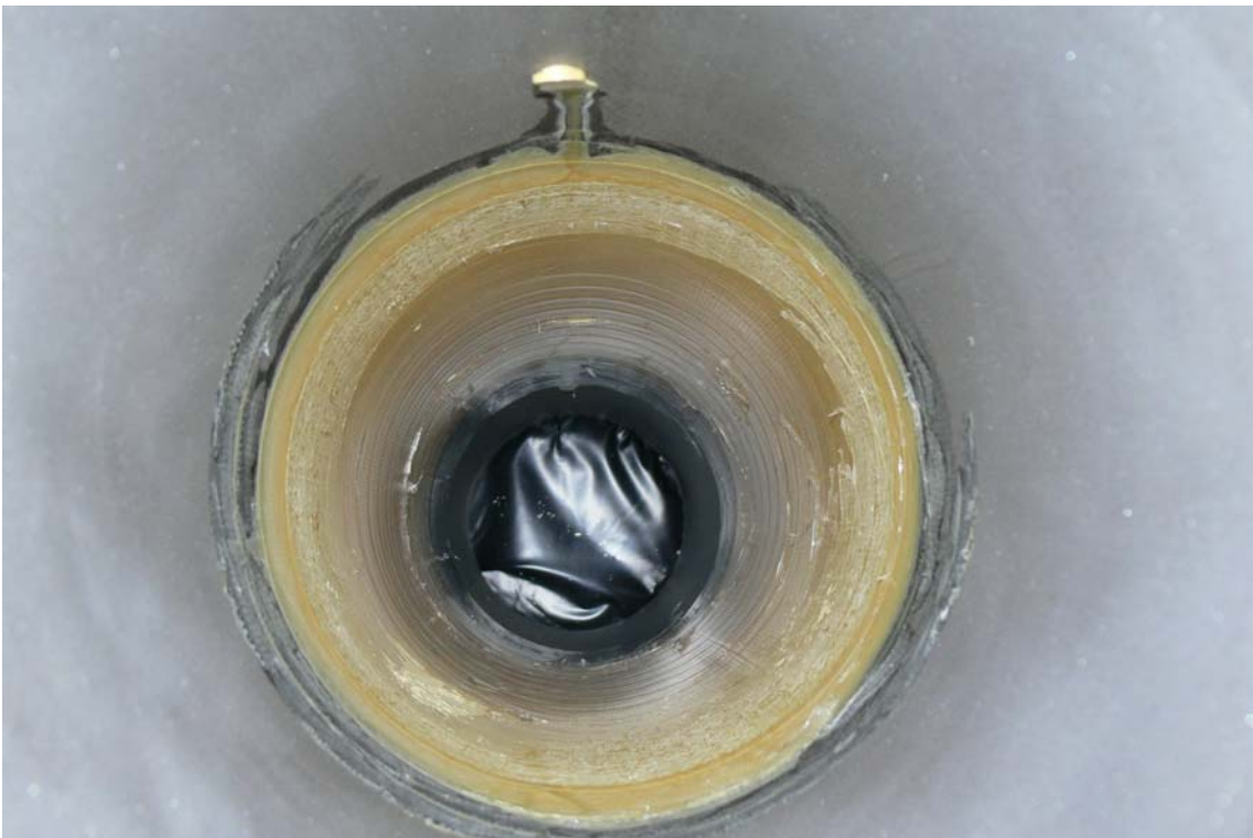
15. ábra. Egy belülről megerősített DN200-as csőszál.
