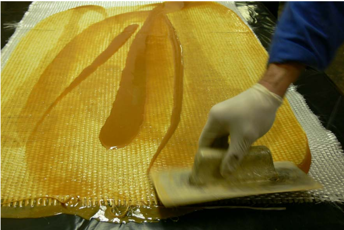
11. ábra. Egy DN200-as csőszál belső megerősítése: a vázanyag impregnálása.
