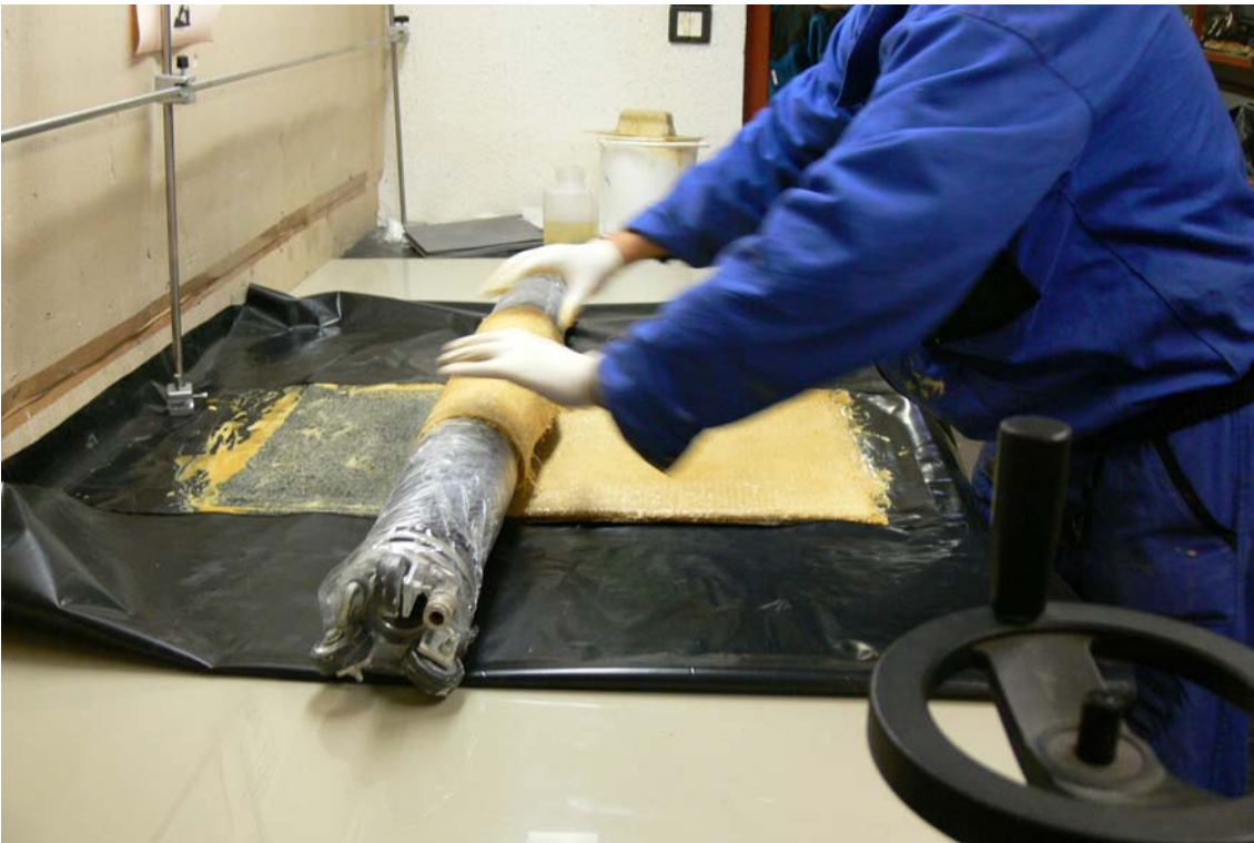
12. ábra. Egy DN200-as csőszál belső megerősítése: az impregnált szövet feltekerése pakkerra.
