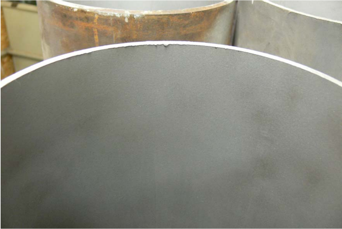
10. ábra. Egy DN200-as csőszál belső megerősítése: a csőfelület előkészítése.
