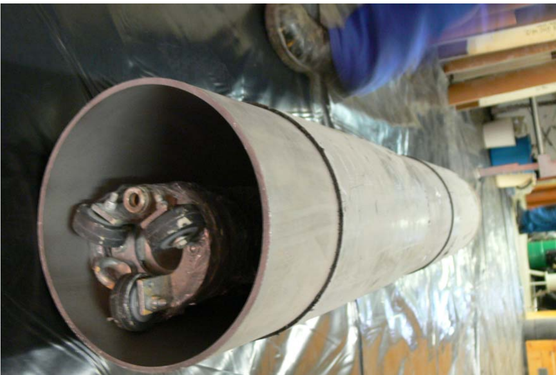
13. ábra. Egy DN200-as csőszál belső megerősítése: a pakkér pozicionálása.
