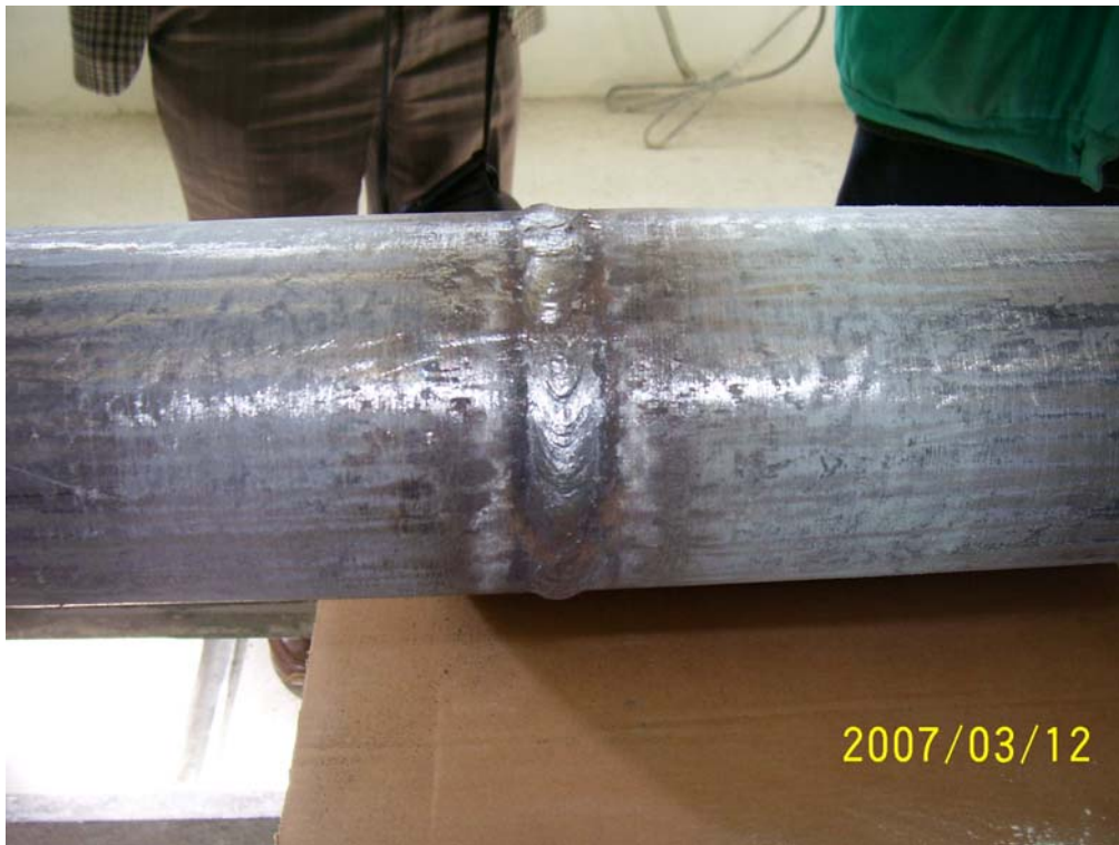
2. ábra. Egy DN 100-as csőszál külső megerősítése: tisztítás.
