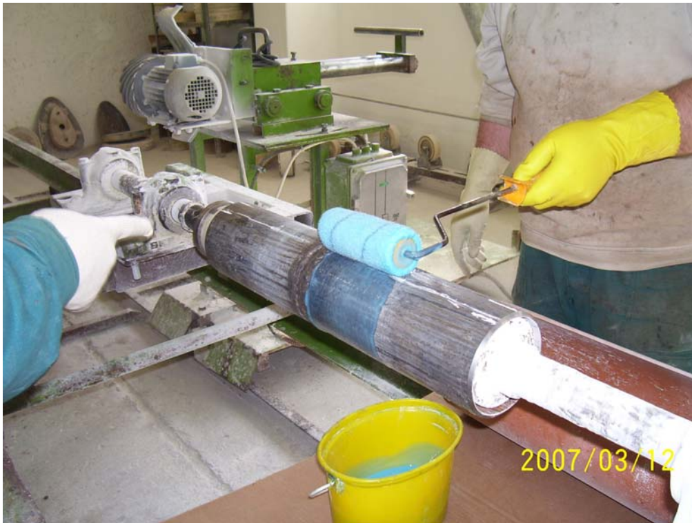
3. ábra. Egy DN 100-as csőszál külső megerősítése: az alap gyantaréteg felhordása.
