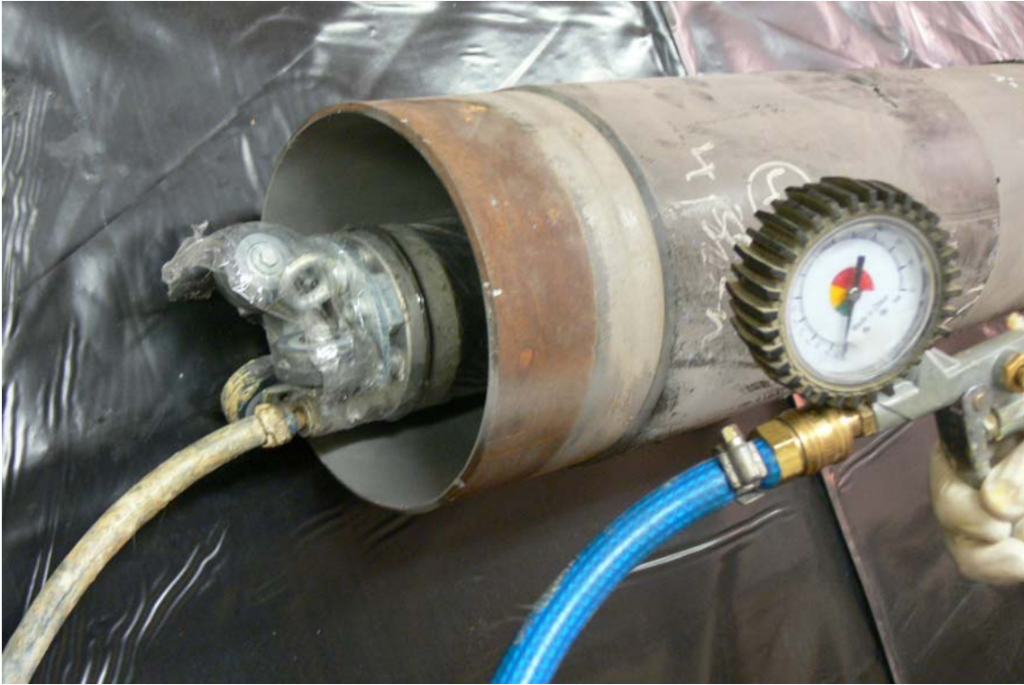
14. ábra. Egy DN200-as csőszál belső megerősítése: a belső nyomás biztosítása.
