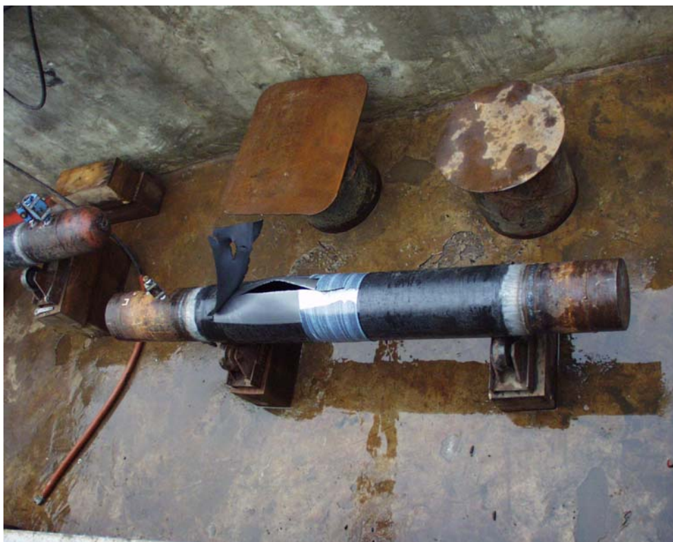
35. ábra. A kívülről megerősített DN 200-as csőszakasz (b4) a repesztővizsgálat után.
