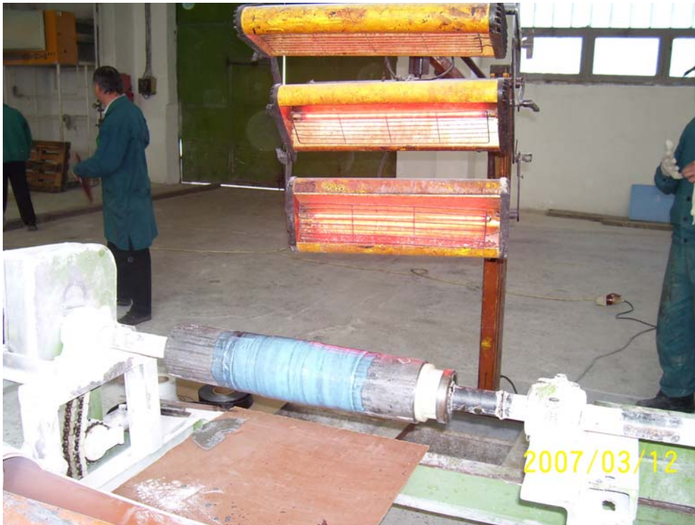
7. ábra. Egy DN 100-as csőszál külső megerősítése: kikeményítés.
