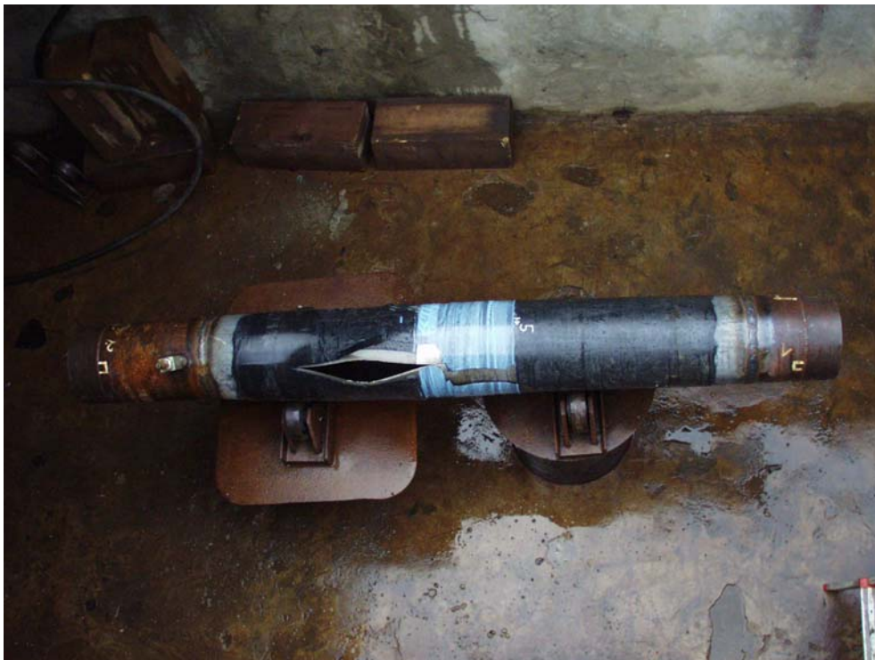
38. ábra. A kívülről megerősített DN 200-as csőszakasz (b5) a repesztővizsgálat után.
