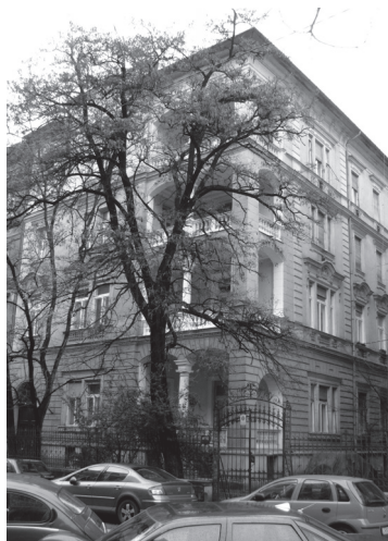
Gábor Dénes szülőháza (VI. kerület, Rippel Rónai utca 25.) éppen Szilárd Leó gimnáziumával szemben. Az épület bejáratánál nehezen olvasható emléktábla van
