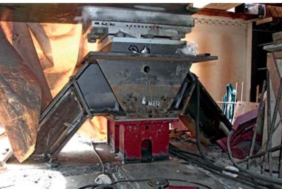
17. ábra Az V. támasz bennmaradó acélszerkezete [6]
