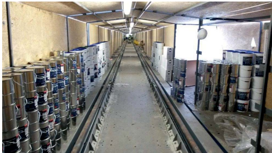
4. kép Fűtött, kivilágított sátor az előkészített Edilon anyaggal
