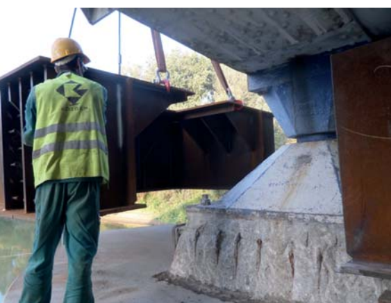
18. ábra A VI. támasz bennmaradó acélszerkezete
