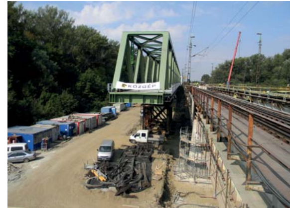
3. kép A már lefestett északi híd megérkezik a hullámtérbe...
