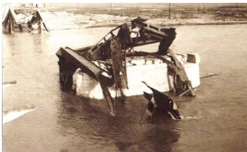
7. ábra A felrobbantott mederhíd és a provizórium [4]
