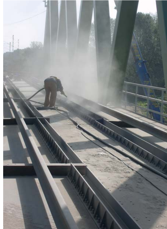
A síncsatorna homokszórásos tisztítása
