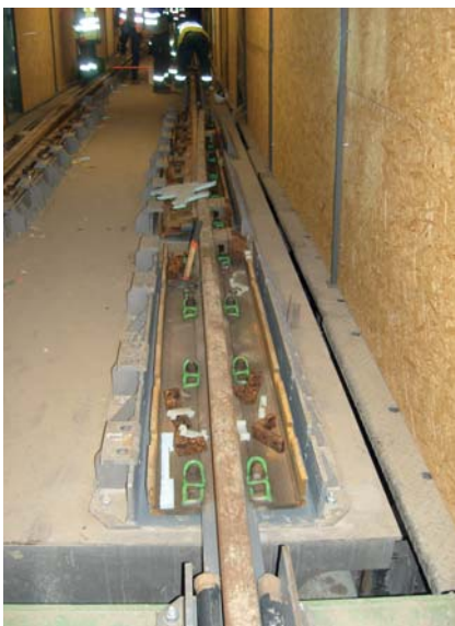
VM rendszerű síndilatáció beépítés közben
