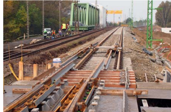
3. kép Szintetikus hídfák az úszólemezen és beépítésre váró dilatációk
