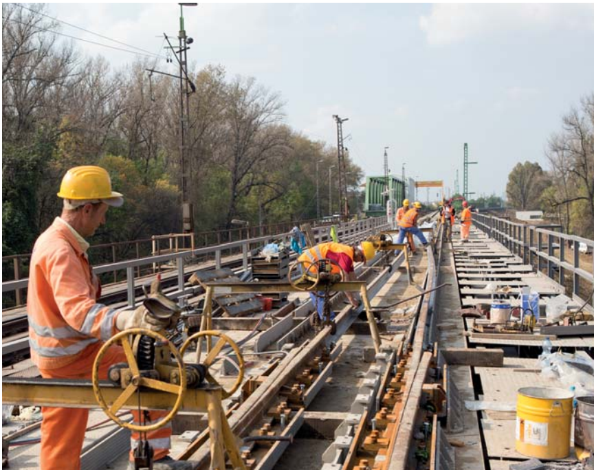
2. kép Edilon rögzítésű dilatáció elhelyezése az ártéri szerkezeten
