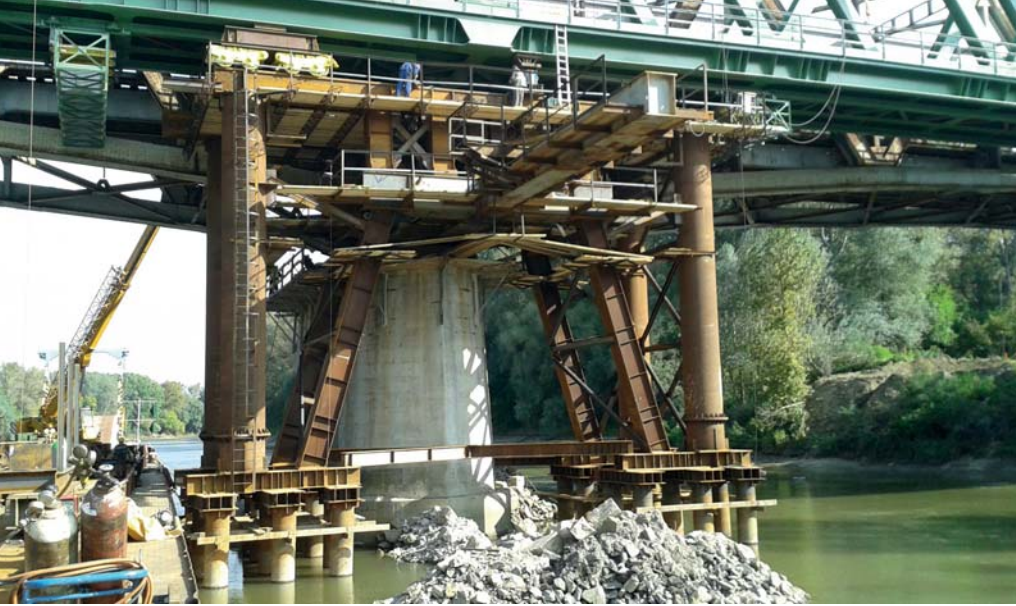
12. ábra Mederpillér melletti egyedi járomszerkezet
