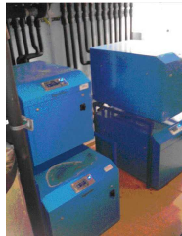
10. ábra. Alföld Aqua Termálfürdő és Strand épület külső és hőközpontja a magyar fejlesztésű és gyártású növelt hőmérsékletű hőszivattyúkkal
