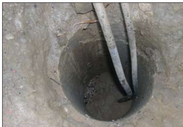
3. kép: Két szondacső párhuzamos hurokba kötve a bentonitos ki-töltéssel 46)
