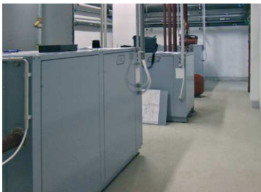
7. ábra. A kiskőrösi termálfürdő új hőszivattyús hőközpontja és új épületrészei Forrás: Geowatt Kft. és Kőrösvíz Kft. (Irodalom, 5.10. ábra)
