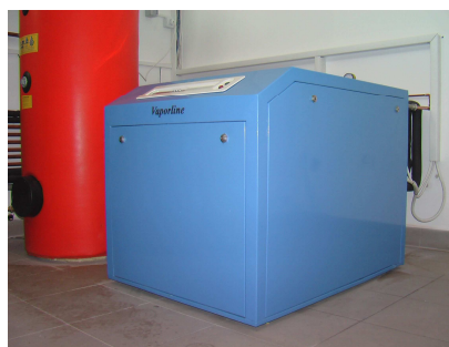
5. ábra. A Vaporline® GBI13-HACW (B/W) hőszivattyú bukaresti beépítése (a 180 m 2 -es családi ház homlokzata és hőközpontja; a rendszerhez 3 db 100 m hosszú, U-hurkos földszonda csatlakozik) Forrás: Geowatt Kft.
