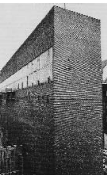
Transzformátorház a Dob utcában, építés: Lestyán Ernő, 1969
