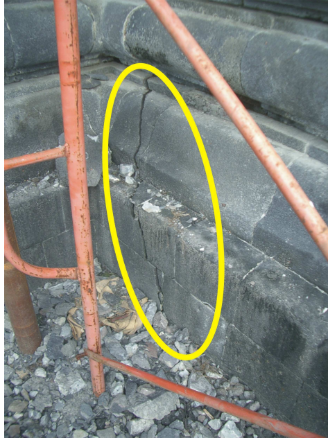
6. ábra. A Brahma-szentélyt ÉNy-DK irányban átszelő balos oldaleltolódás. A felszínen 4 mm az elmozdulás.
