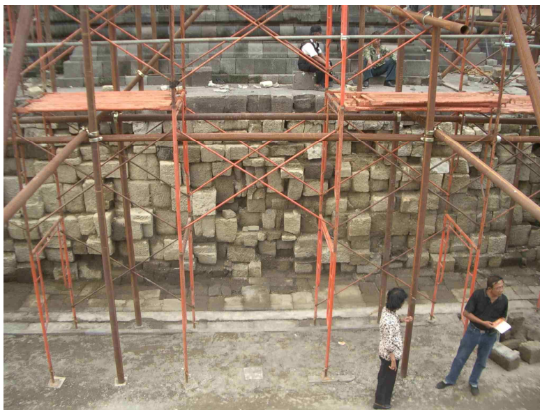
11. ábra. A Visnu-szentély alsó részéről lebontották a külső, faragott kőburkolatot (2008. május állapot). Láthatóvá vált az építmény magja: fehér színű, puha vulkáni tufa. A díszes, aprólékos faragásokat egy sötét, keményebb, az időjárásnak ellenálló vulkáni kőzetben formálták meg. Habarcsot nem alkalmaztak az építésnél.
