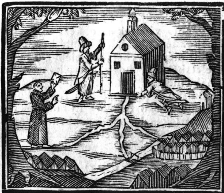
7. kép A máriaradnai kápolna szultáni engedéllyel történő felújítása.
